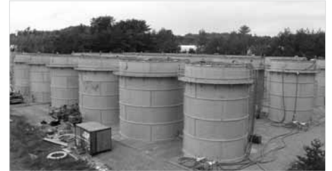
Verstrahlte Wassertanks am AKW 1 in Fukushima.
