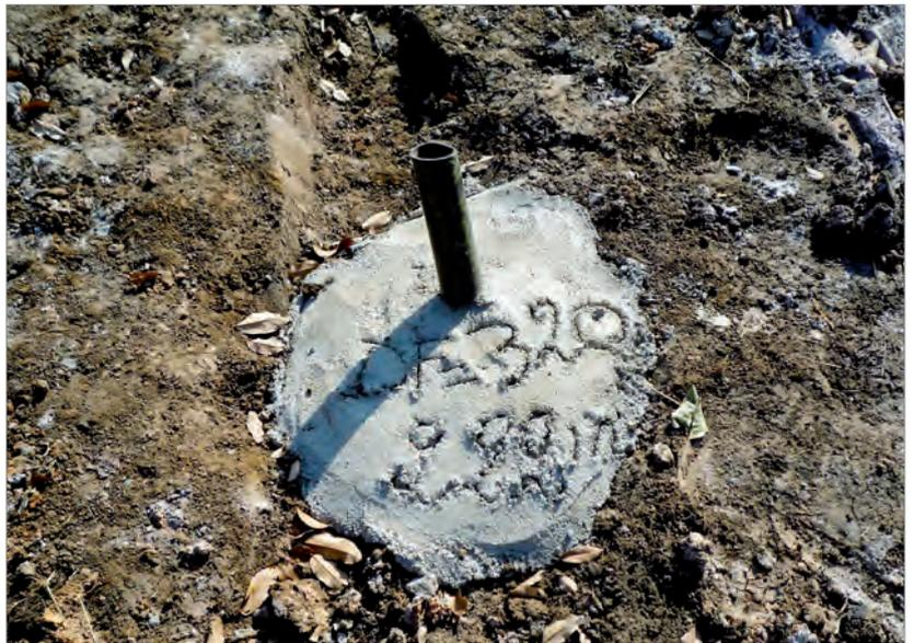
*Zeugnis einer sogenannten Explorationsbohrung*
