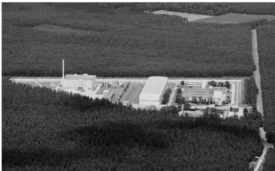
Das Zwischenlager Gorleben mit der zentral gelegenen Castorlagerhalle
