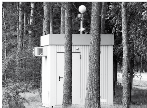
Schutzhaus für Strahlenmess-Sensoren am Zwischenlager Gorleben (im Bild Messhaus 1 am Haupttor). Die runde Kugel auf dem Dach beherbergt den Sensor für Neutronenstrahlung, weitere Sensoren befinden sich im Inneren.
