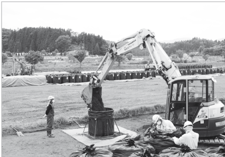
Arbeiter tragen kontaminierte Erde ab und verpacken sie in Plastiksäcke.
