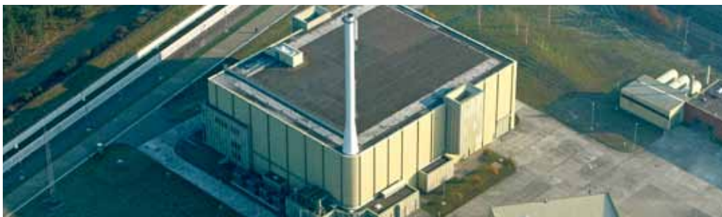
Als heiße Zelle unbrauchbar: Die Pilotkonditionierungsanlage (PKA) in Gorleben
