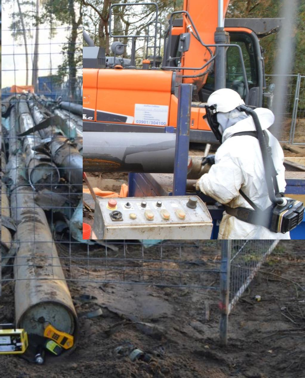
Kontaminierte Erdgasrohre, hier Nassgasleitung DN 300 vom Gassammelpunkt Mehmke zur Erdgasstation Heidelberg, noch 1.000 km müssen ausgebaut und gereinigt werden um Salzwedel/Sachsen-Anhalt
