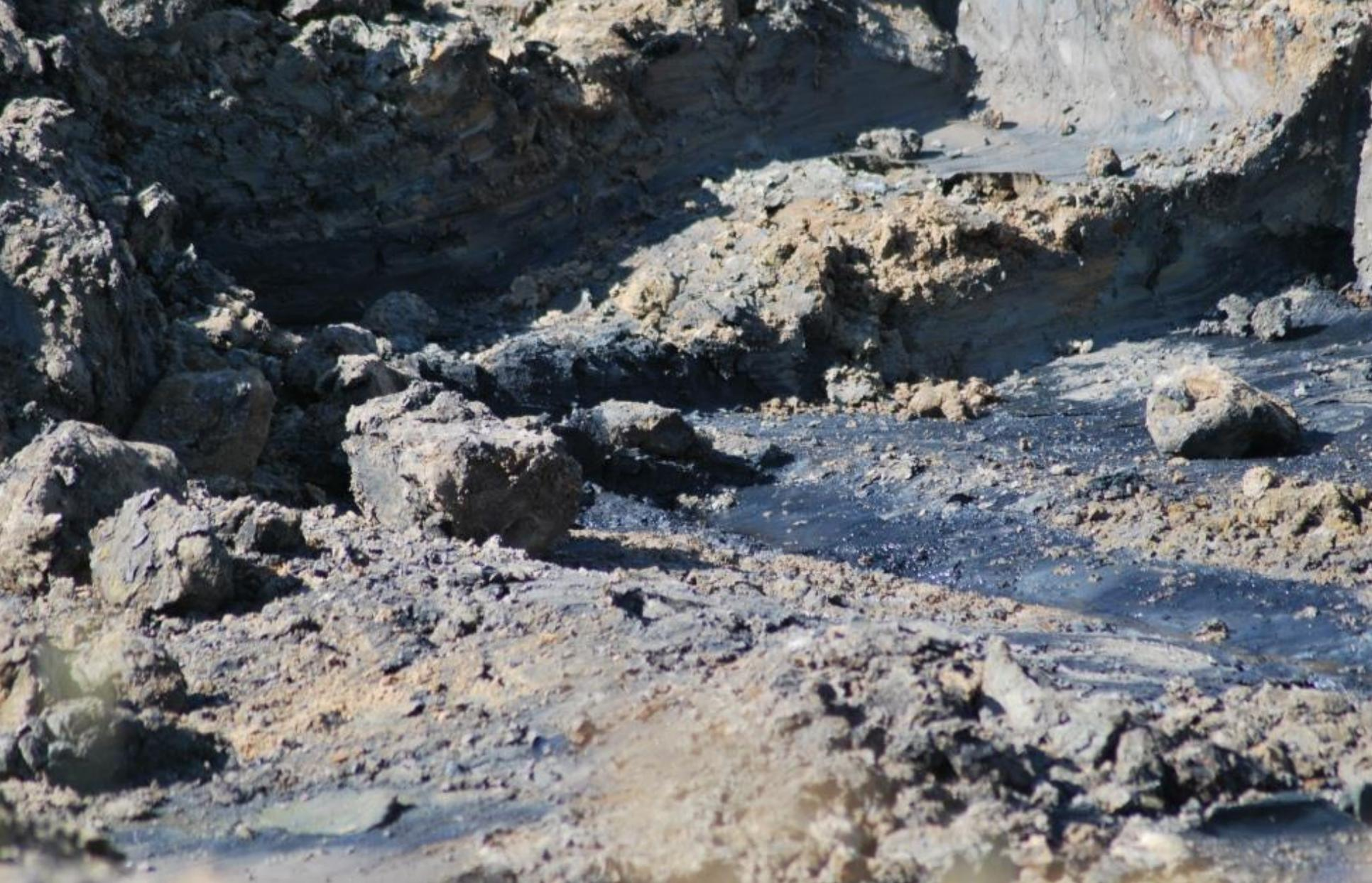
Bohrschlamm der Erdgasbohrung Pes 154 aus 1971. 2018 wurde u. a. ölhaltiger Bohrschlamm unter Getreidefeld, saniert, ausgekoffert und entsorgt.
