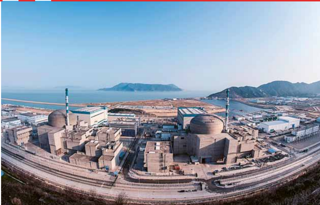
Mit Hilfe von EDF aus Frankreich: Atomkraftwerk Taishan in der chinesischen Provinz Guangdong
