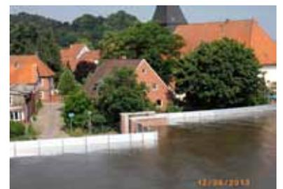
79 Zentimeter Freibord, also weit mehr als die propagierte „Handbreit Wasser“, hatte die Hochwasserschutzwand 2013 in Hitzacker
