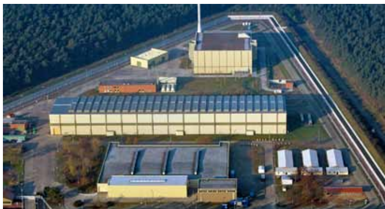
Die PKA (oben) soll abgerissen werden, die Zwischenlager für hoch- (gr. Halle) und mittlradoaktiven Müll (unten) bleiben.
