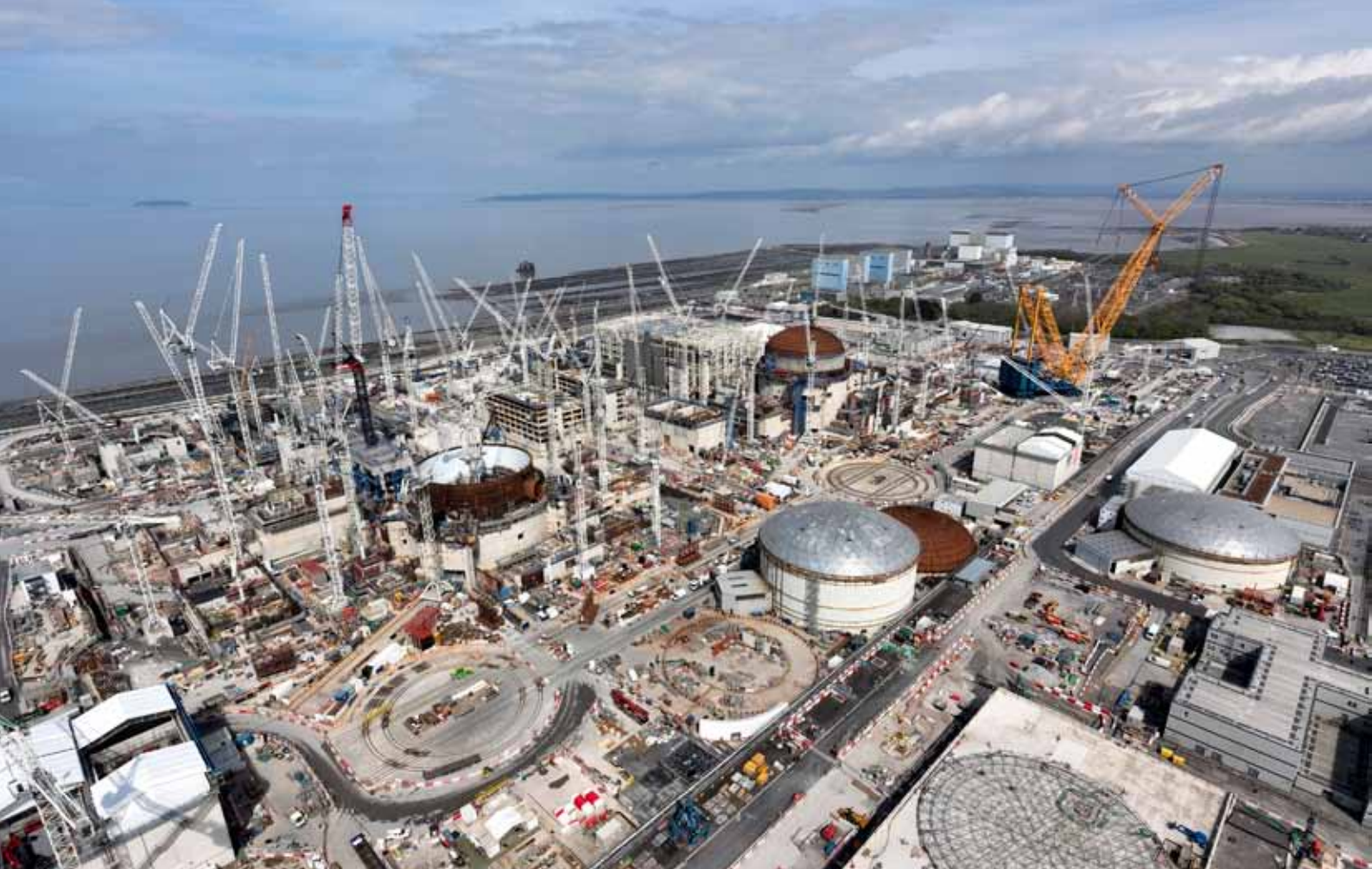
Baustelle des AKW Hinkley Point C in Großbritannien
